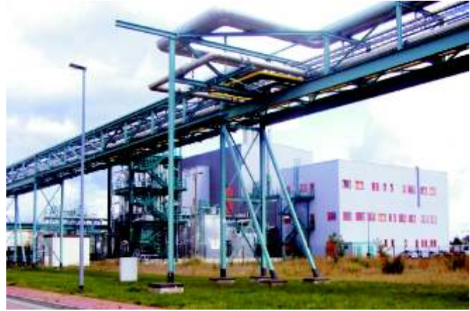
Rohrbrücken am Standort Bitterfeld-Wolfen
